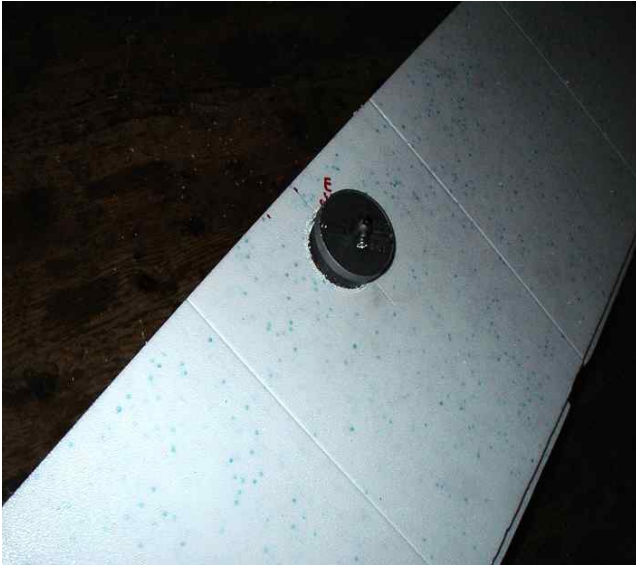
Einbau der Mauerdurchführung mit Loch- und Stichsäge “
